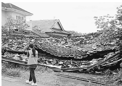
益城町に隣接する熊本市沿山津の現状
