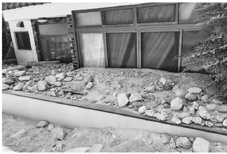
一階部分の半分まで堆積した土砂
