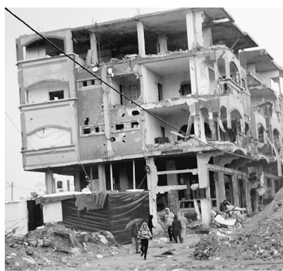
2015年の空爆で破壊されたガザの建築物
